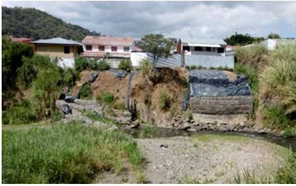
Figura 1. Socavación y deslizamiento en la margen derecha del cauce del río María Aguilar, cantón de Curridabat, Costa Rica (febrero de 2018).
