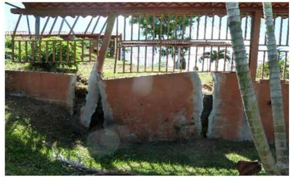
Figura 2. Aspecto de la fracturación del terreno, causada por el deslizamiento activo en el sector urbano de la ciudad de Puriscal, Costa Rica (agosto de 2015).
